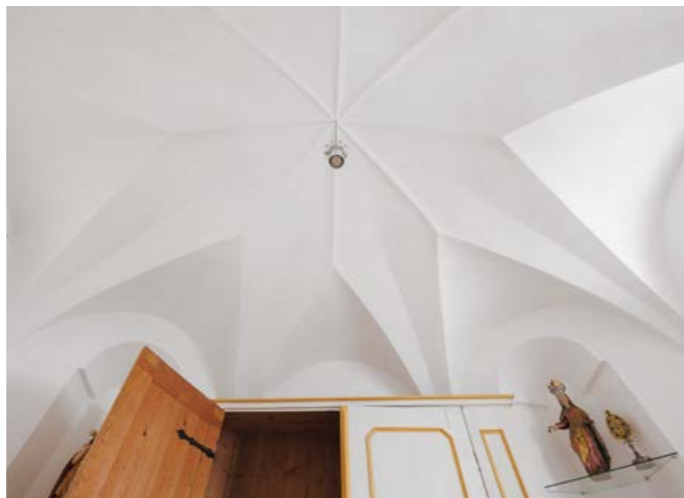
SAKRISTEI / SCHATZKAMMER GEWÖLBE
