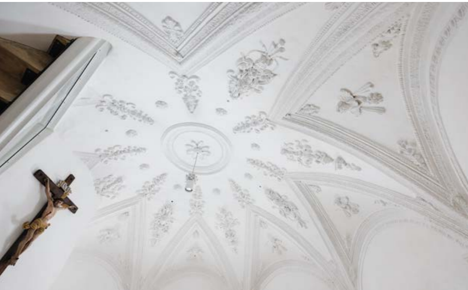
SAKRISTEI GEWÖLBE ENDZUSTAND
