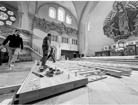
Aufbau Podestanlage
