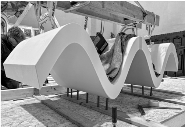
Verankerung erste Altarwelle in Podestanlage
